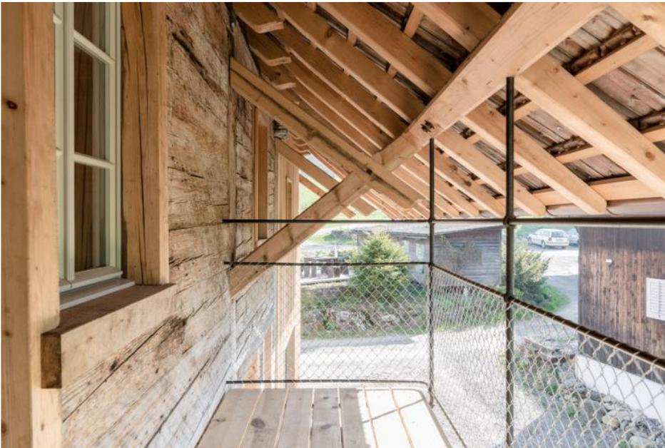
Detail Balkon als leichte Konstruktion. Bild: Aurel Martin
